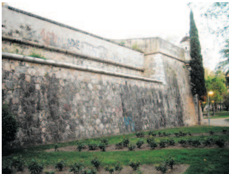
Fig. 2. Baluarte de San Vicente. Podemos apreciar que el recerido del baluarte está terminado mientras que el nuevo revestimiento de la cara no llegó a concluirse.
