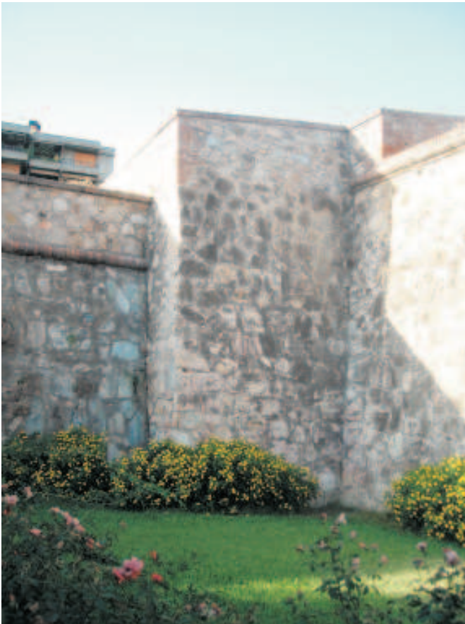
Fig. 3. Diferencia de altura entre cortinas y baluartes
