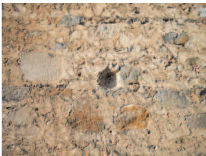
Fig. 8. Una de las balas de cañón empotrada en el muro del Metido.
