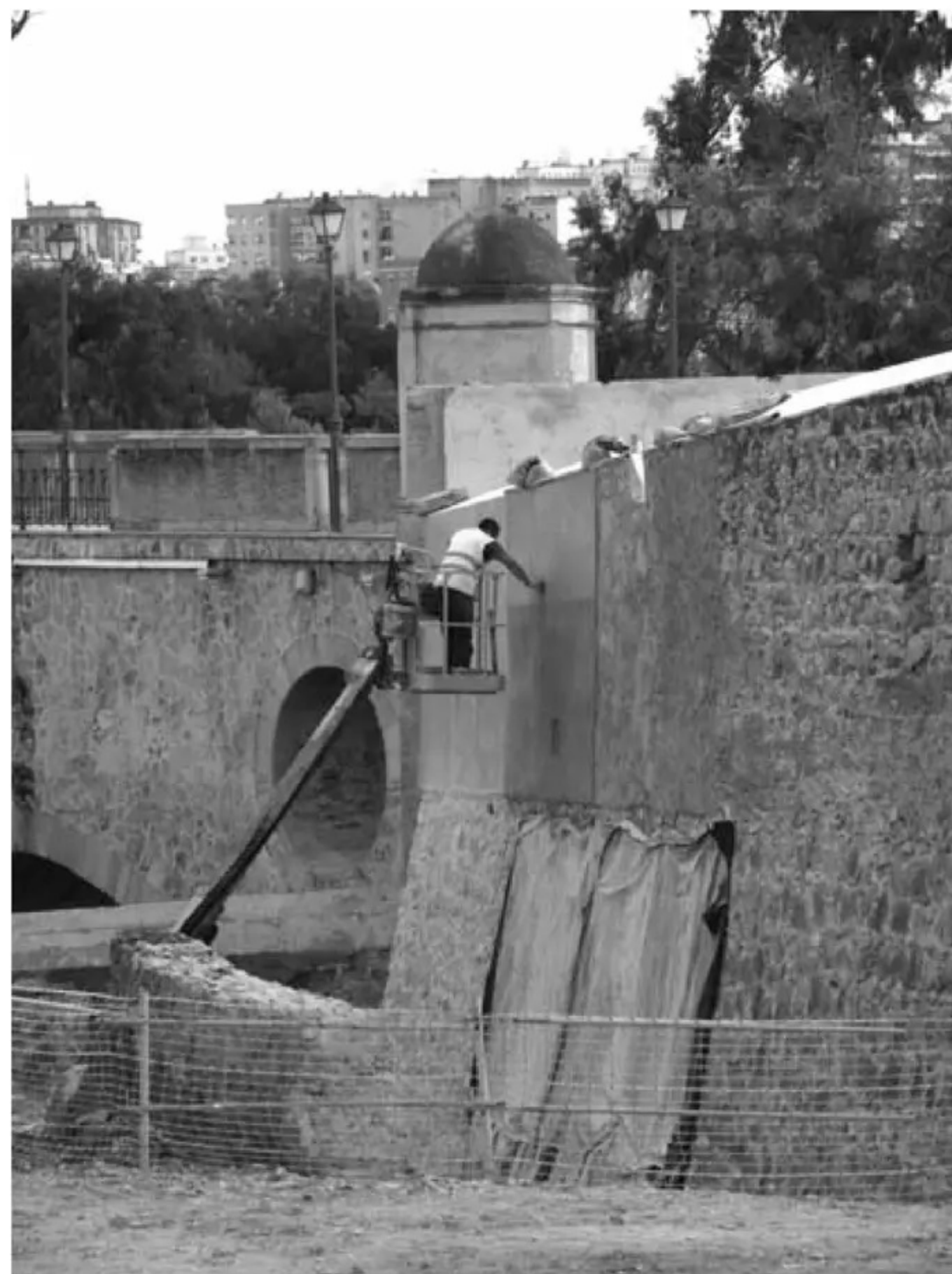
Trabajos de rehabilitación (Diciembre, 2010)
