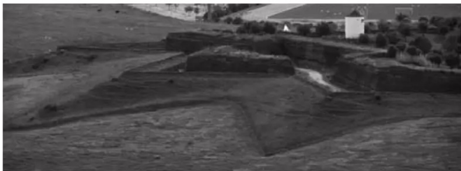
Revellín protegiendo la cortina entre dos baluartes (Elvas, Portugal)
